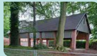
De dragende muren en de houtstructuur van het dak werden hersteld en geschilderd.
