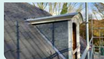
Dakwerken zijn afgerond
